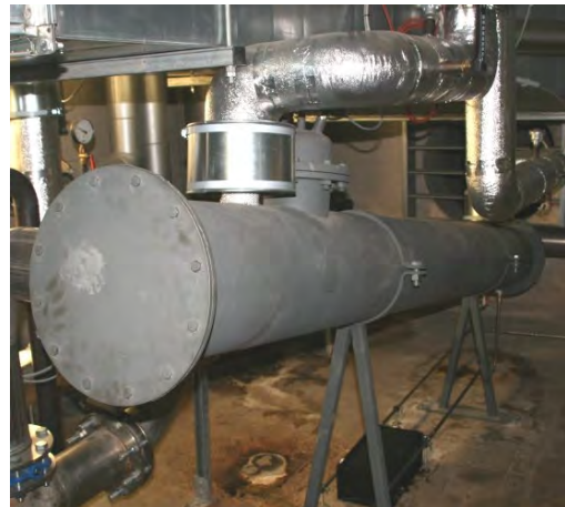
Abbildung 17: Heizungsraum im Keller (Altbaubereich) mit den beiden BHKW-Anlagen (links) und einem der beiden Abgaswärmetauscher (rechts)
