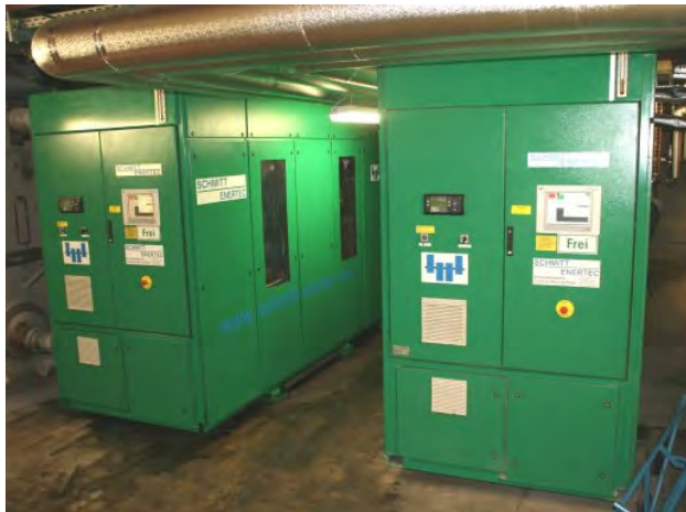
Abbildung 17: Heizungsraum im Keller (Altbaubereich) mit den beiden BHKW-Anlagen (links) und einem der beiden Abgaswärmetauscher (rechts)
