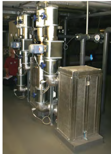
Abbildung 19: Links : Detail der Wärmeversorgung mit NT- („BHKW Abluft“) und HT-Netz aus der Ausführungsplanung zum Beckenwasserkreislauf von Becken 3 (Quelle: Eneratio). Rechts : Foto von einem Wärmeübertrager des Beckenwasserkreislaufs.
